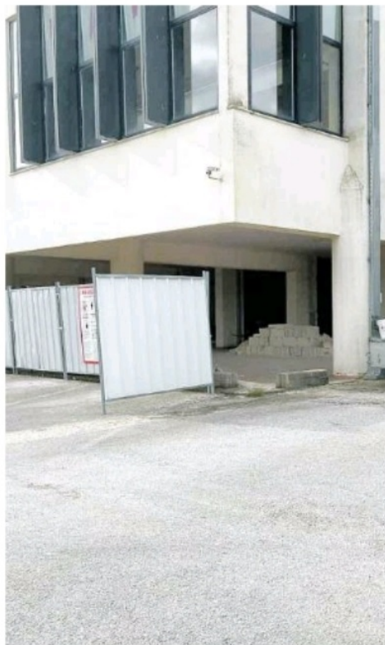
Sopra il cantiere già avviato. A sinistra una veduta del "Majorana"
